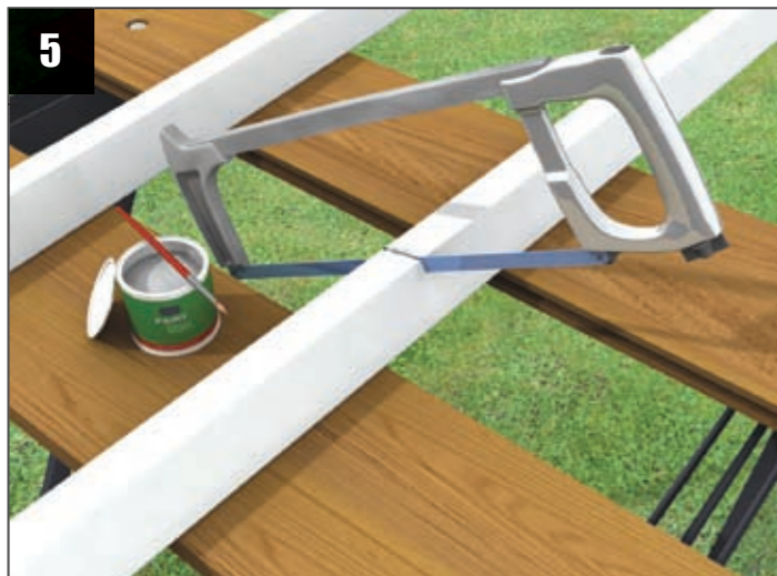
5 S'il y a un besoin de couper quelque chose sur le chantier (les trous pour le drainage ou un trou pour le tuyau de descente) enlever tous les rejets de metal de la surface et puis sceller avec un apprêt et finalement appliquer la première couche de peinture. Autrefois, utiliser un enduit étanche pour empêcher le commencement de la corrosion. Ces mesures sont nécessaires en particulier, dans les environnements marins.
