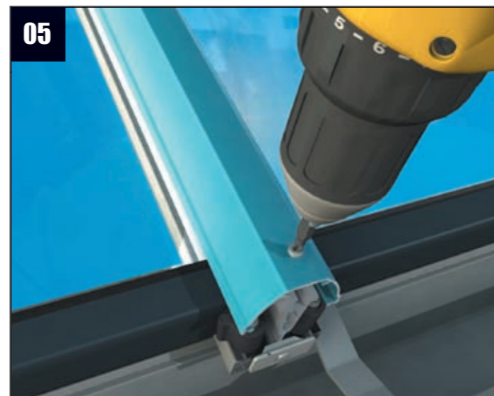
05 Percer un trou de 6mm et puis utiliser la fixation (CRN010) pour attacher le capot sur le chevron. (Pas nécessaire si vous utilisez la corniche)
