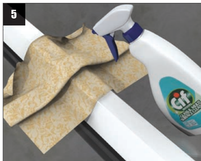
5 On peut enlever les marques difficiles avec la crème de rénovation par exemple. Quand il est sec, on peut faire le polissage.
